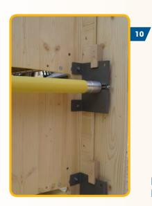
Blende für die Umlenkseite auf die Lagerbleche aufstecken.
